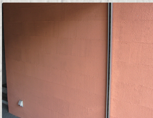
シャッター脇の動きの大きい箇所への塗布。1年半経過後もクラックは再発していません。
