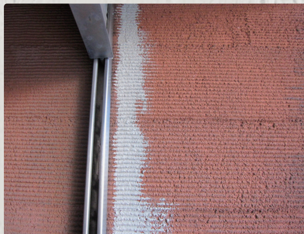
フレスコカラーを擦り込み。フレスコカラーは超微粒子のためパターンが潰れにくい。
