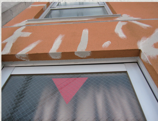
水性アクリル樹脂系塗装材のクラック補修(Sクリートクラック使用)
