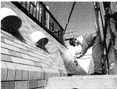
写真-1 斜壁のタイル目地に塗布(工事Ⅰ)
