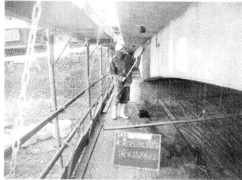
写真-2 塗布作業(主桁側面)
