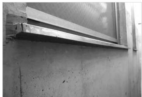
写真-2 注入材施工
