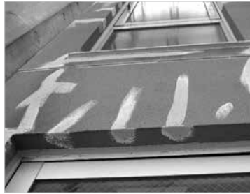
写真-4 注入材施工
