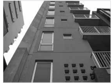
写真-5 1年経過後の外観
