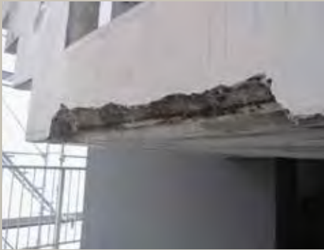
浮き部をはつり、ペガサピンにて鉄筋の防錆処理を施した後、Sクリートアップを塗布。Sクリートアップの効果によりコンクリートの改質・緻密化、アルカリ性回復。また、補修モルタルとの接着性が增强される。
