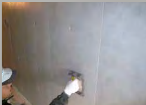
S クリートカラー V 3 回目の塗布。3 回目は黒顔料を混入し、目塗工 N-70 程度に調色し、フェルト材にて叩き塗り。
