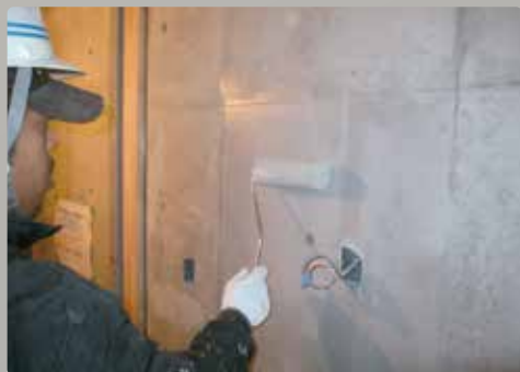
S クリートカラー V を追っかけ 2 回塗布。ローラー使用。
