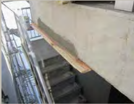
補修モルタルで再成形。
