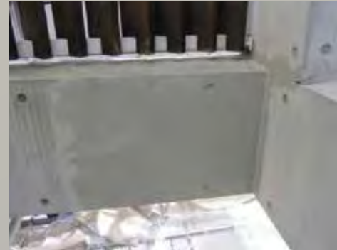
コンクリートの補修(改質)のため、Sクリートアップを塗布後、Sクリートクラック(超微粒子セメント)にて、表面被覆補修をする。Sクリートアップの効果にて、強靱な接着性が保たれる。
