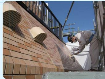
将来のエフロ予防だけでなく、すでにエフロが発生している箇所も、Sクリートガード®を塗布するだけで、エフロの再発を抑制できます。
