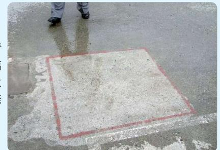
北海道 屋上駐車場コンクリート床 6年経過後の写真（赤枠内のみ試験施工）
