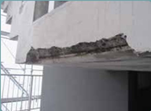
浮き部をはつり、鉄筋の防錆処理をペガサビンで施した後、Sクリートアップを塗布。ペガサビンは浸透性鉄筋防錆材です。
