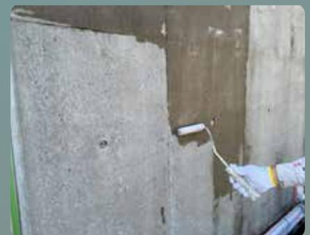
Sクリートアップ塗布。水養生不要のため外壁部への塗布も簡便。
