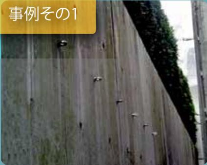
築12年のコンクリート擁壁。汚れと汚垂れが顕著なため、Sクリート・リストア工法で補修を実施。
