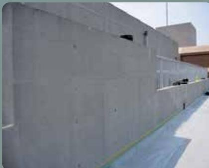
施工完了。コンクリートの美観が甦り、改質・防水保護されています。
