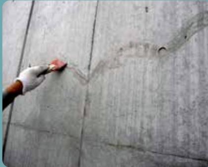
Sクリートアップ塗布後 Sクリートクラックをゴムベラにてすり込み作業。Sクリートアップの効果によりコンクリートの改質・緻密化、アルカリ性回復。また補修モルタルとの接着性が增强されます。
