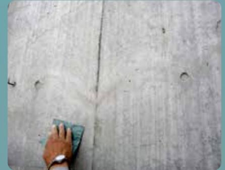
Sクリートクラックによる補修後は、サンドペーパーをかけると補修跡が目立たなくなります。
