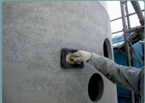
SクリートカラーVの施工時にボカシ用専用スタンプ台を用いることでぼかし塗りも可能
