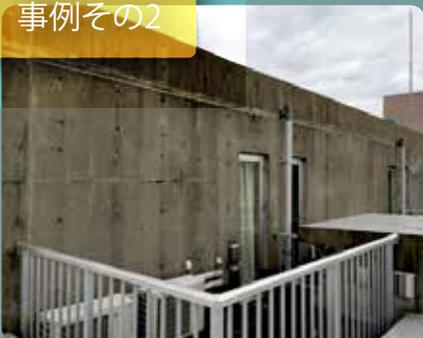
築12年のコンクリート打放し構造物。外壁の汚れが顕著。
