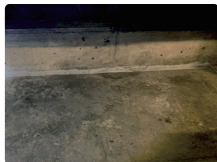
床と壁との塵際にもSクリートクラックを刷毛にてしごき塗る。
