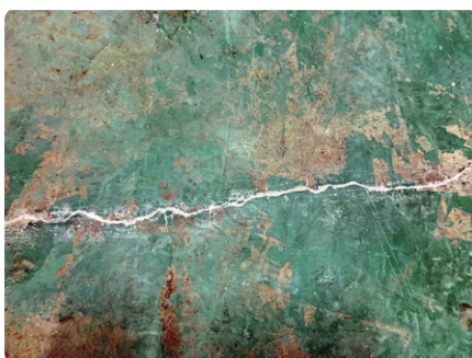
顕著なクラックには[Sクリートクラック工法]をゴムベラにてすり込む。
