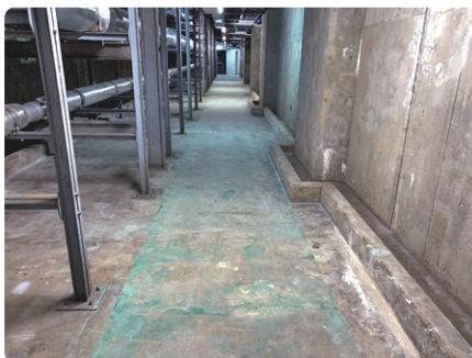
顕著なクラックには[Sクリートクラック工法]をゴムベラにてすり込む。
